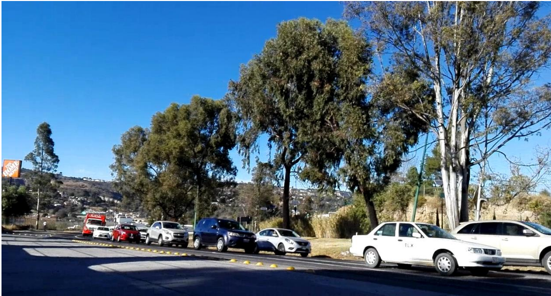
FOTO 3.- Vista Carretera: Puebla – Belén sentido 2 km. 32+360 (PFP)
